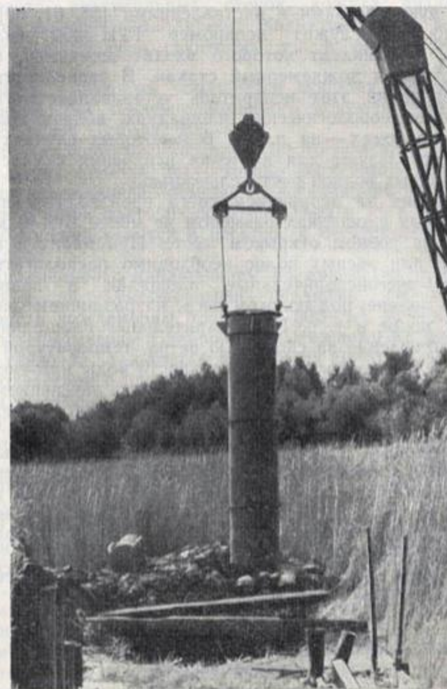
Рис. 20. Зарядка 2-5-метрового монолита лизиметра ГР-80.
