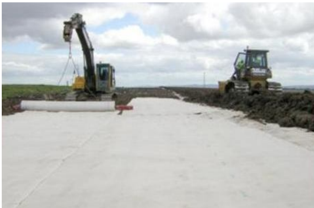
Рисунок 5 – Укладка бентоматов с защитным слоем из грунта на накопителе отходов
