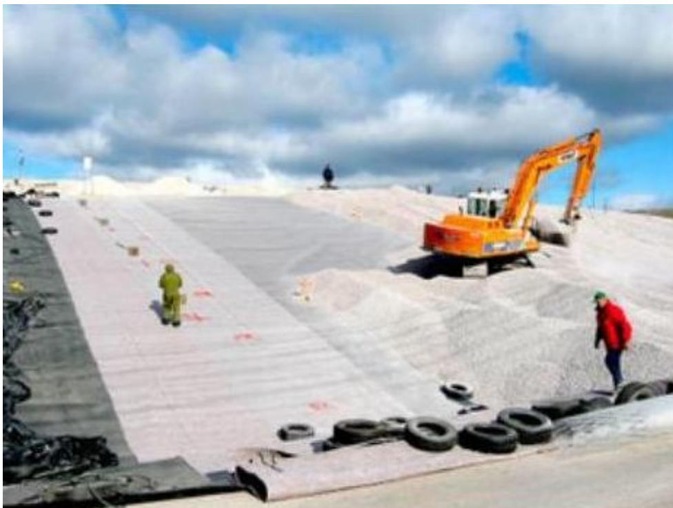
Рисунок 4 – Реконструкция накопителя отходов с применением геосинтетических материалов
