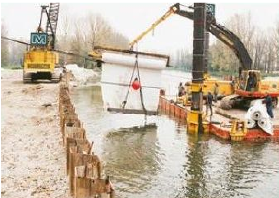
Рисунок 1 – Укладка бентоматов в канал Дортмунд-Эмс
