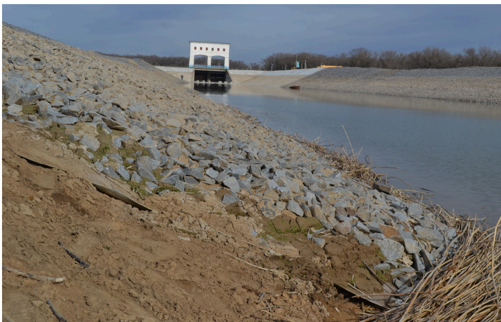
Рисунок 3 – Участок ДМК с противофильтрационным экраном из бентоматов
