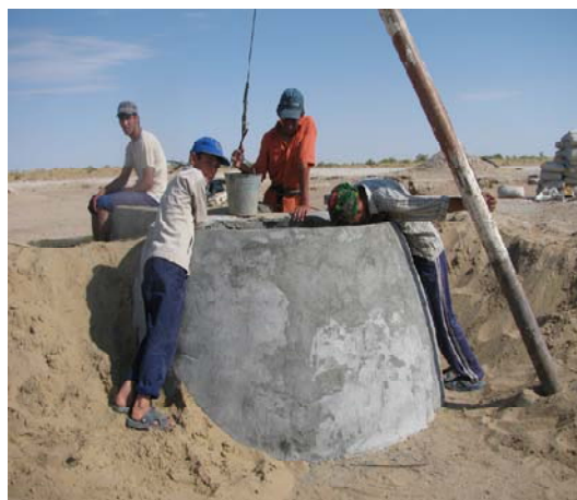
Рисунок 9 – Выемка песка из колодца слоем 1 м
