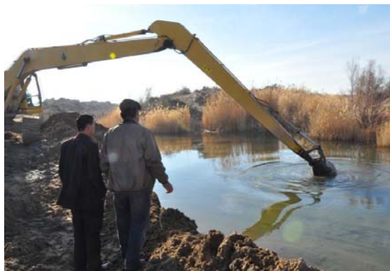
Рисунок 3 – Углубление русла коллектора
